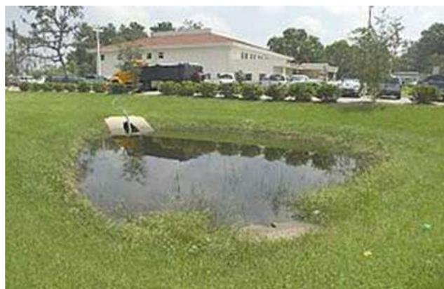
Figura 14: Lagoa de retenção. Fonte: SuDS Wales, c2024l, p.1. Disponível em: <<https://www.sudswales.com/types/passive-treatment/retention-ponds/>>. Acesso em: 23 jan. 2024.
