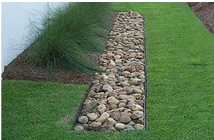
Figura 6: Exemplo de trincheira de infiltração. Fonte: SuDS Wales, c2024d, p. 1. Disponível em: <<https://www.sudswales.com/types/source-control/infiltration-trenches/>>. Acesso em: 18 jan. 2024.
