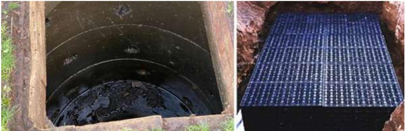
Figura 9: Exemplos de poços de drenagem com anéis de concreto (esquerda) e com caixas plástica de malha aberta (direita). Fonte: Rowe, 2017, p. 1. Disponível em: <<https://www.asllimited.co.uk/drainage-blog/what-rainwater-soakaway/>>. Acesso em: 31 jan. 2024.
