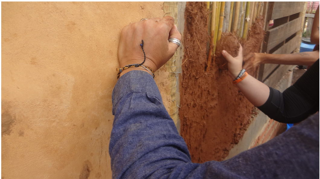
Figura 6 – Quincha recebendo uma camada da mistura feita (Proteção extra). Fonte: Arquivo pessoal (2023).
