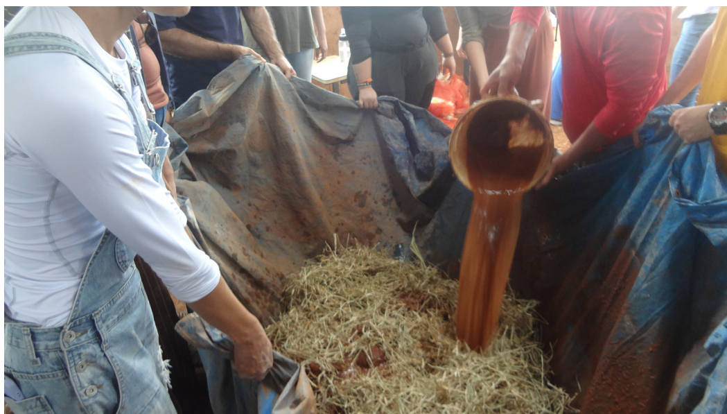
Figura 4 – Mistura de terra, água e palha de arroz em lona a ser movimentada de um lado para outro a fim de otimizar a mistura. Fonte: Arquivo pessoal (2023).
