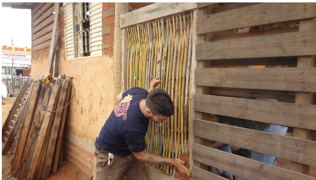
Figura 7 – Quincha peruana explicada pelo Instrutor da Oficina de bioconstrução. Fonte: Arquivo pessoal (2023).
