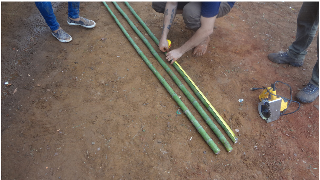
Figura 1 – Bambus selecionados e medidos para serem cortados por máquina de corte, visando melhor acabamento. Fonte: Arquivo pessoal (2023).
