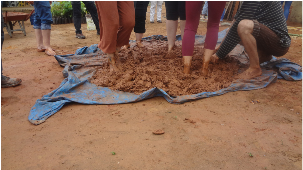
Figura 5 – Composto de terra, água e palha de arroz sendo apurado e prensado por pés e mãos dos participantes. Fonte: Arquivo pessoal (2023).
