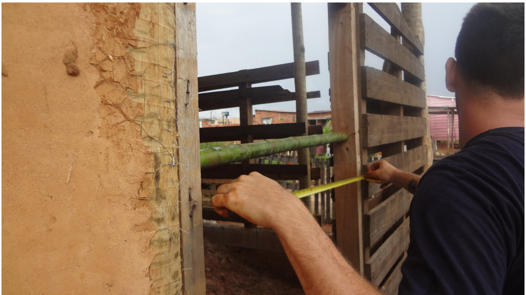
Figura 2 – Base da estrutura da quincha formando uma moldura de pallets e primeiros bambus inseridos na horizontal para formar a quincha. Fonte: Arquivo pessoal (2023).
