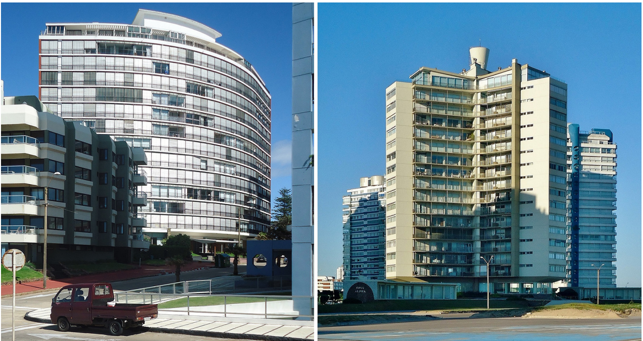
FIGURA 8 – O Edifício Lafayette (esquerda) com as fachadas revestidas com persianas metálicas; e o Edifício Opus Alpha , com o ingresso entre os dois strips comerciais curvos.
