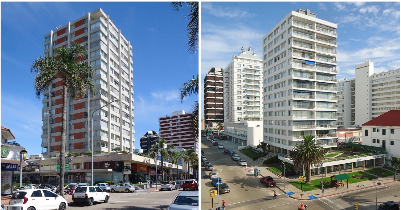
FIGURA 10 — O Edifício Apolo (esquerda), sobre a plataforma que reconfigura a rua-corredor; e o Edifício Castelmare com a solução engenhosa da base.
