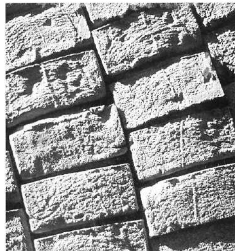
Quarteirão de S. Michele in Borgo, 1974-. Detalhe construtivo da fachada, arco de tijolos. (foto de Marcos Tognon)
