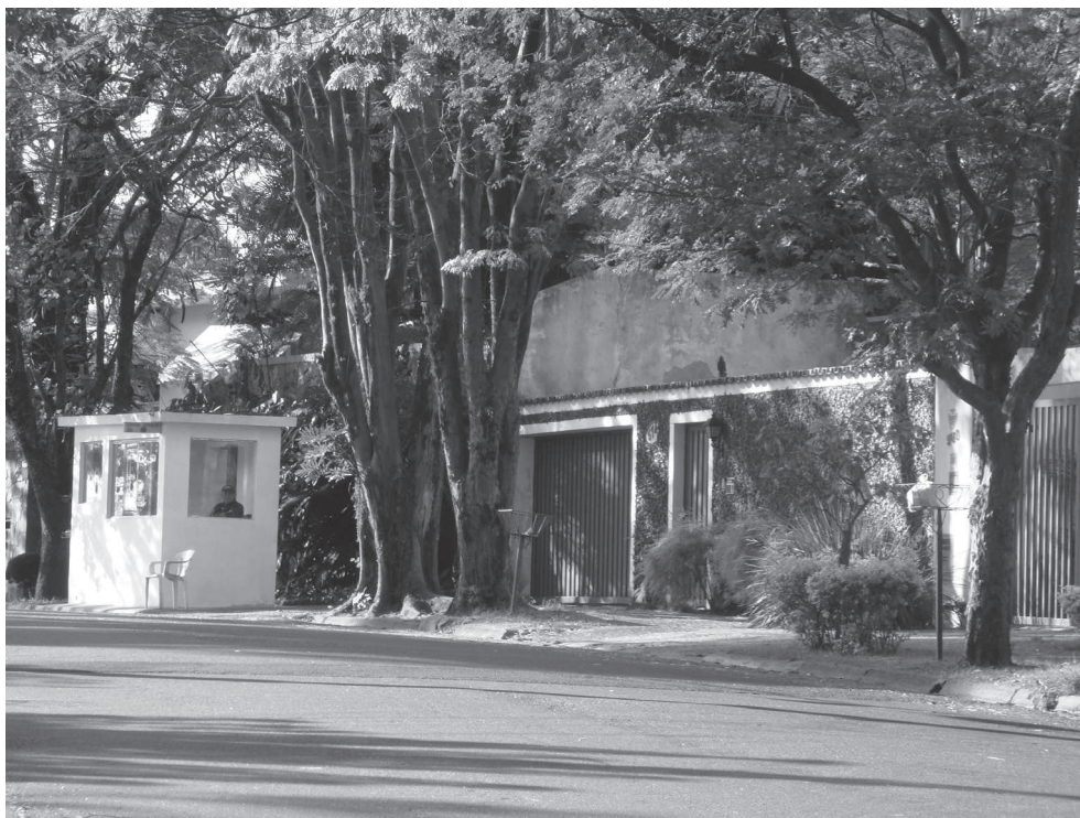
FIGURA 8 – Fachada de residência no Parque Ecológico, correspondente ao setor censitário 350950205000723. Fonte: Elaborado pelo autor.
