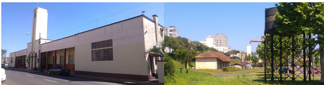
FIGURA 2 – Montagem fotográfica mostrando a estação ferroviária, a caixa d'água e o armazém 1.
