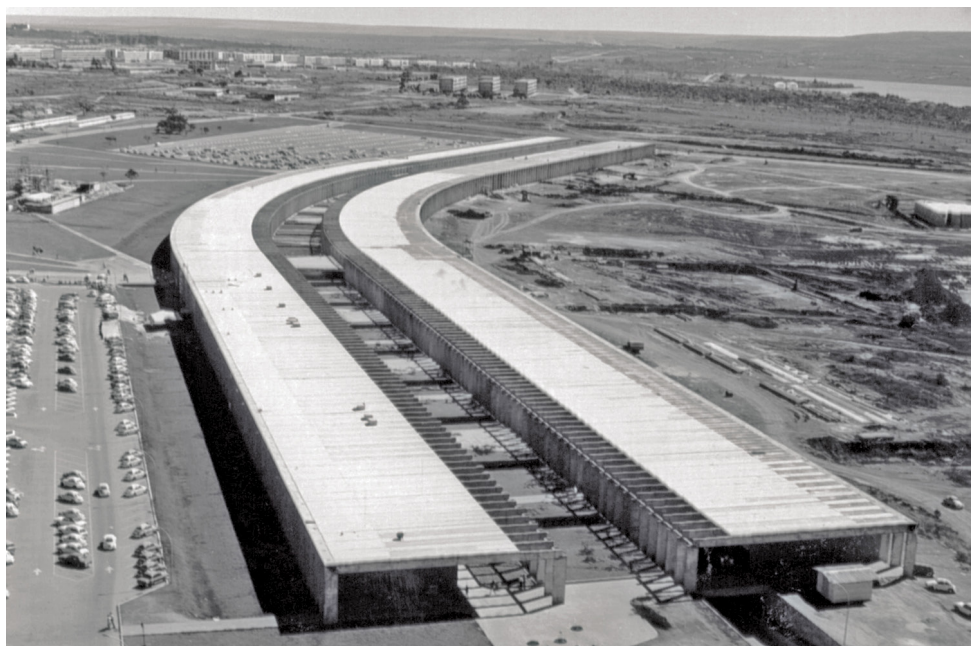
FIGURA 1 – Vista aérea do Instituto Central de Ciências – ICC/UnB, em foto de 1972.
