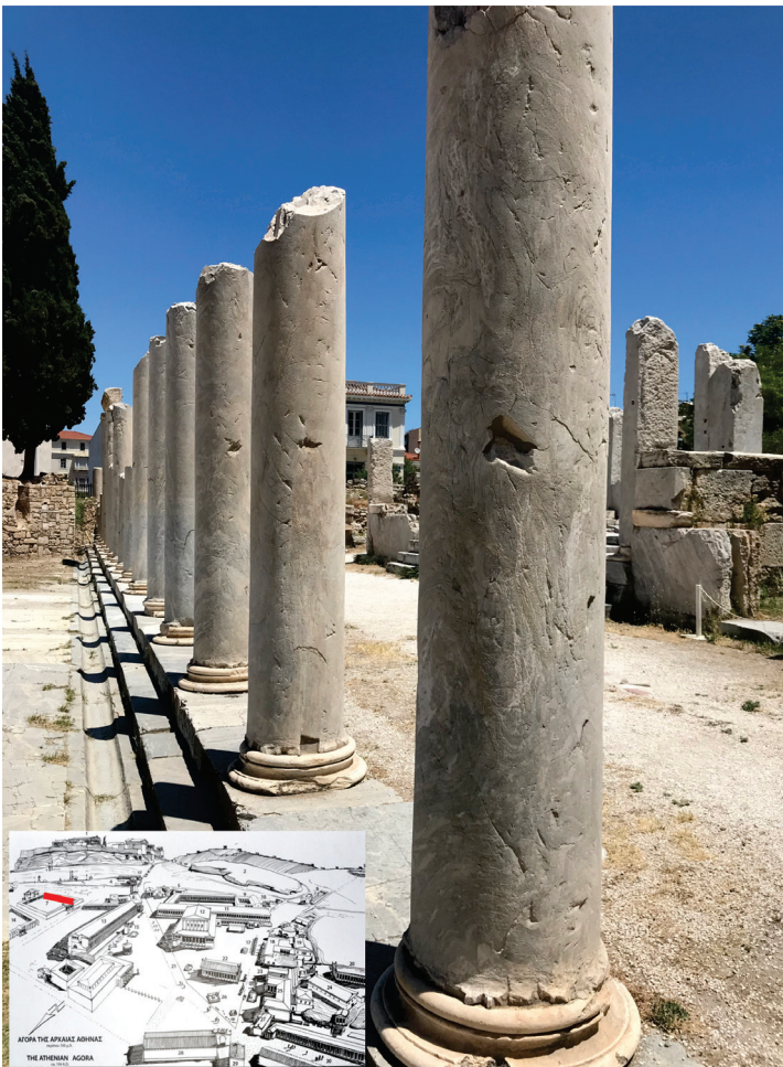
FIGURA 8 – Remanescentes dos pórticos da Ágora Romana de Atenas.
