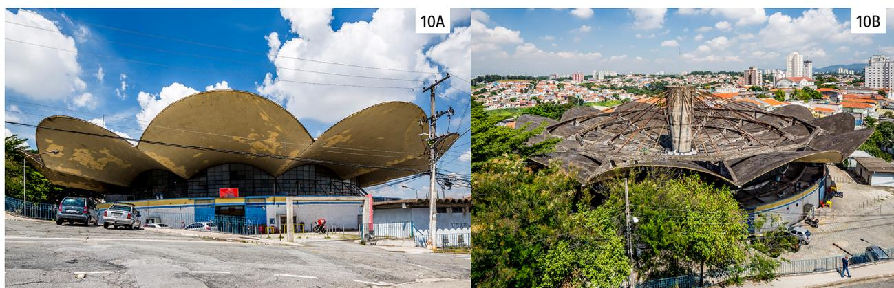
**FIGURA 10** — (A) Vista atual da entrada pela rua Almirante Noronha; (B) Vista superior da cobertura com tirantes e as vigas radiais, além das de travamento.
