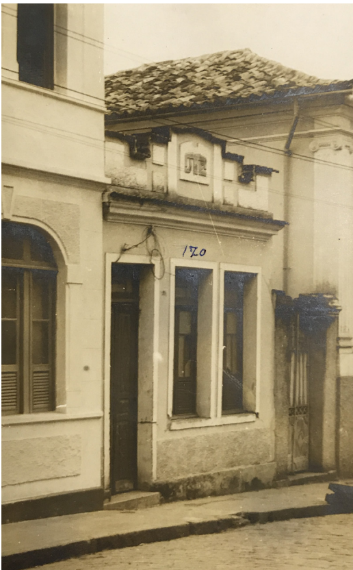
FIGURA 4 – Edificação número 170 da rua Getúlio Vargas antes das obras de intervenção.
