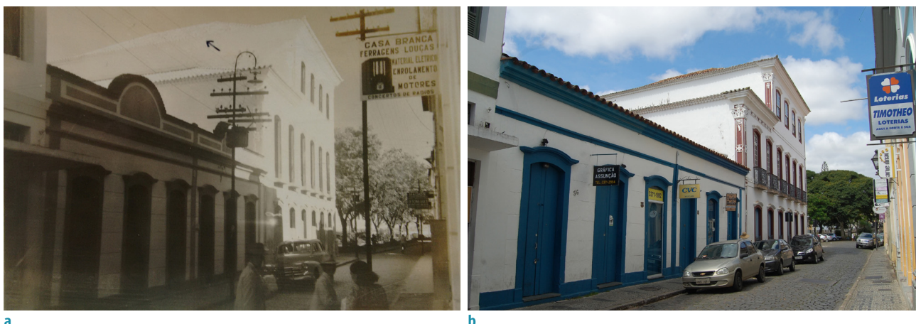
FIGURA 3 – Registros da edificação número 28 da rua Marechal Deodoro.
