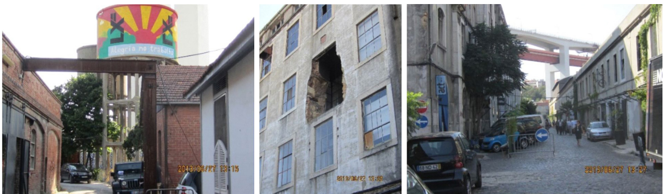
FIGURA 1 – Edifícios industriais da LX Factory em junho de 2013.
