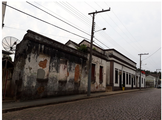
Conjunto de três edificações da Vinícola Cadorin (URU002). Data de Construção: 1927 (edificação principal).
