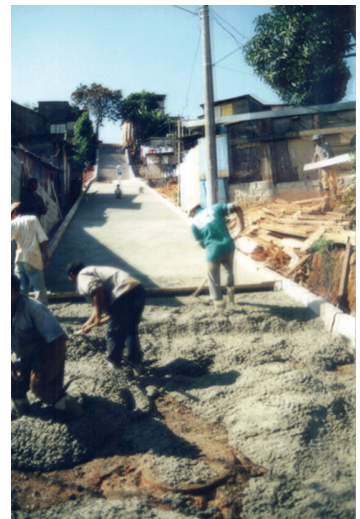
Figura 5 — Desenvolvimento da abertura de viela na Tamarutaca com o acompanhamento da Peabiru em obra — em construção. Fonte: Acervo Peabiru TCA (2003).
