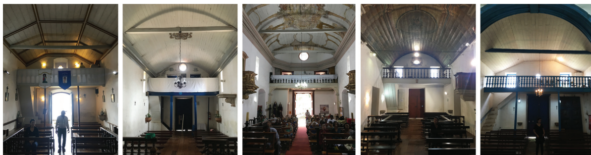
FIGURA 6 — Interiores das Capelas de Ouro Preto, com as barras inferiores das tesouras aparentes. Capela de Sant’Ana, Capela de Nossa Senhora da Piedade, Capela do Padre Faria, Capela do Bom Jesus das Flores do Taquaral e Capela de São João Batista.
