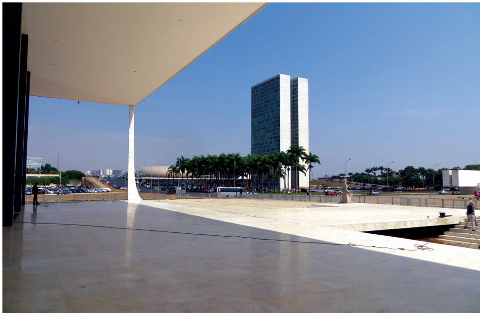
FIGURA 1 — Edificio del Supremo Tribunal Federal, Brasília (DF). Fuente: Foto de los autores (2014).
