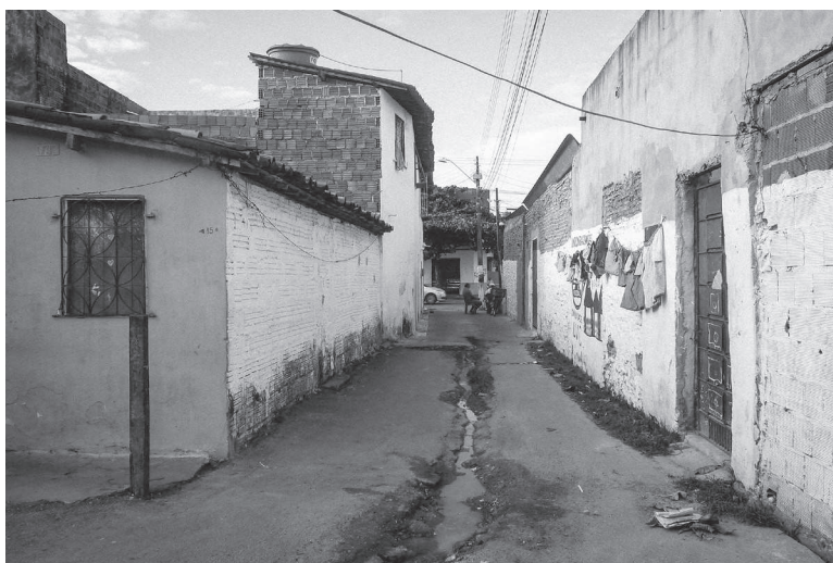
FIGURA 2 — Processo de transformação na Comunidade Lauro Vieira Chaves. FONTE: Camila Matos Fontenele (co-autora) (2013).
