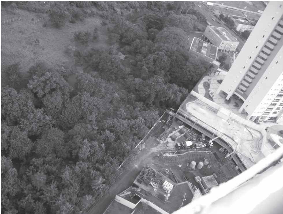
FIGURA 7 – Vista parcial da Área de Preservação Permanente do córrego Prosa e obras do Condomínio I. Campo Grande (MS). Fonte: Arquivo pessoal (2008).
