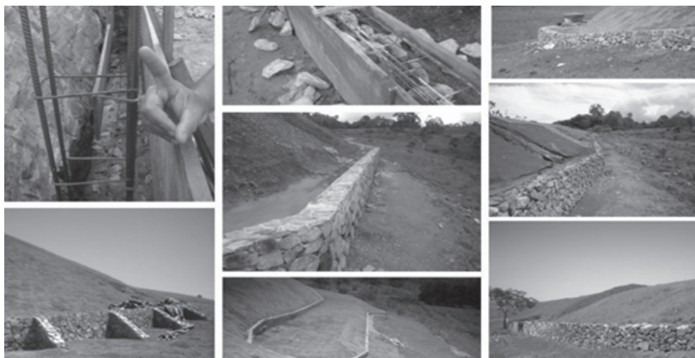
FIGURA 13 – Muros de arrimo. Fotos: Mara Araujo/abr. 2006.
