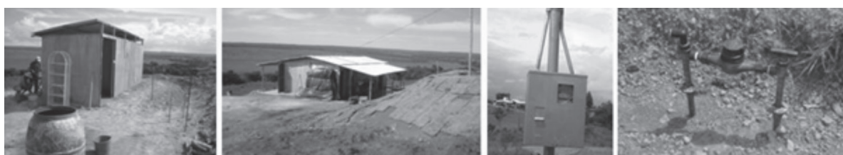
Figura 8 – Canteiro de obras. Fotos: Mara Araujo/fev. 2006.
