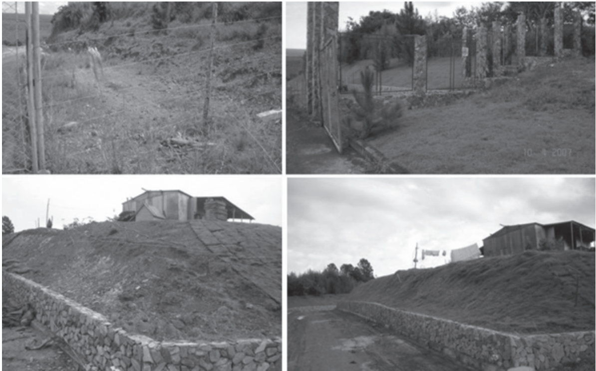
FIGURA 21 – Muros de arrimo. Fotos: Mara Araujo/jan. 2006 e jan. 2007.
