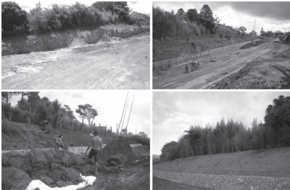
FIGURA 20 – Arrimo na pista de acesso ao condomínio. Fotos: Mara Araujo/jan. 2006 e jan. 2007.
