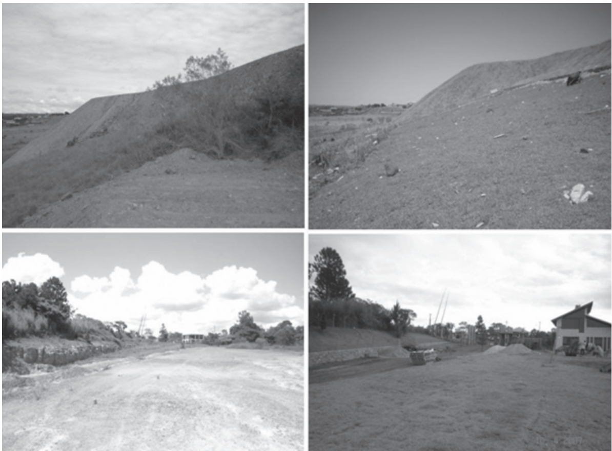
FIGURA 22 – Vista geral 1. Fotos: Mara Araujo/jan. 2006 e jan. 2007.
