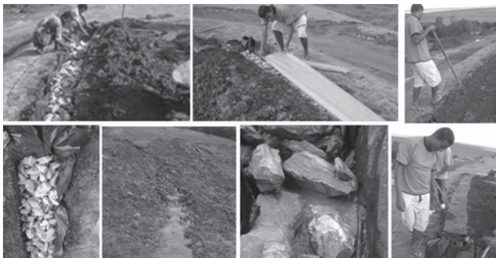
FIGURA 12 – Construção de drenos. Fotos: Mara Araujo/mar. 2006.
