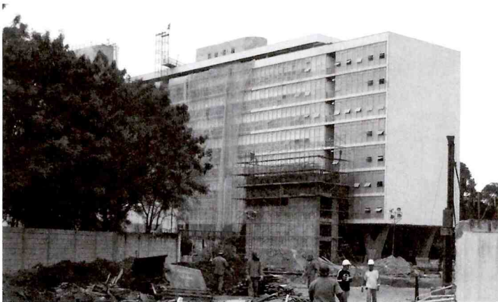
FIGURA 4 – Vista posterior do edifício do Palácio da Agricultura durante os trabalhos realizados de construção das escadas de emergência, transferidas para a fachada posterior do edifício.
