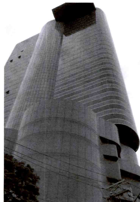
FIGURA 5 – Complexo Ohtake Cultural, Torre Faria Lima, São Paulo (2004). Fonte: Disponível em: < http://www.wikiarq.com/projetos/21/instituto-cultural-tomie-ohtake >. Acesso em: 15 nov. 2011.
