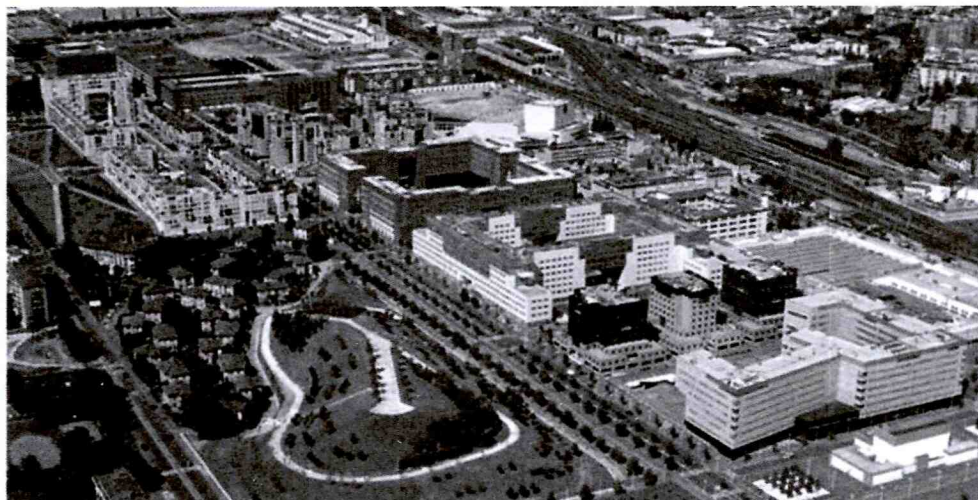
FIGURA 1 – Transformação da área La Bicocca — Milão 1985.
