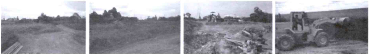
FIGURA 10 – Movimento de terra e corte de terreno. Fotos: Mara Araujo/fev. 2006.
