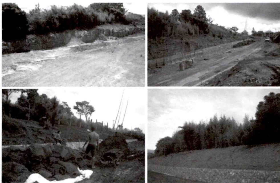
FIGURA 20 – Arrimo na pista de acesso ao condomínio. Fotos: Mara Araujo/jan. 2006 e jan. 2007.
