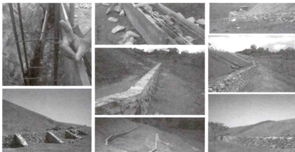
FIGURA 13 – Muros de arrimo. Fotos: Mara Araujo/abr. 2006.
