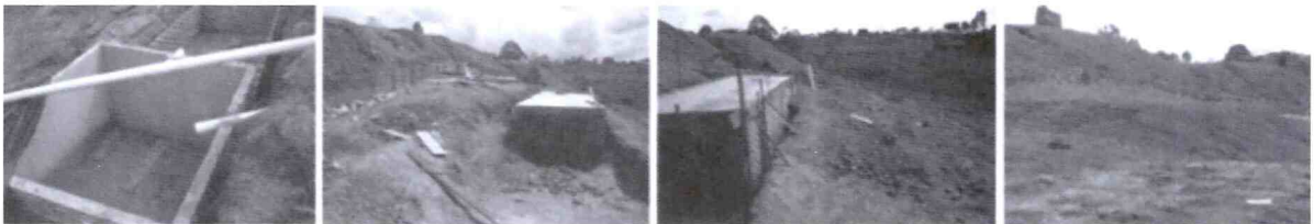
FIGURA 11 – Construção de fossa. Fotos: Mara Araujo/fev. 2006.
