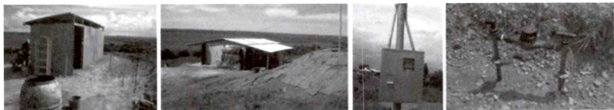
Figura 8 – Canteiro de obras. Fotos: Mara Araujo/fev. 2006.
