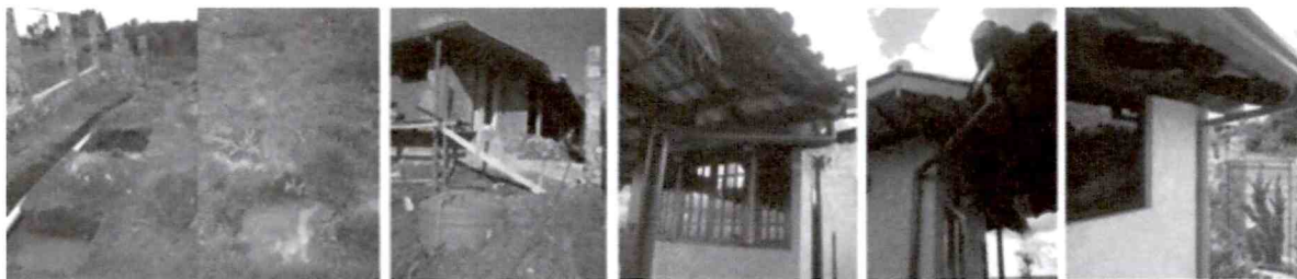
FIGURA 16 – Caixas de visita de filtros e captação de água da chuva. Fotos: Mara Araujo/jan. 2007.
