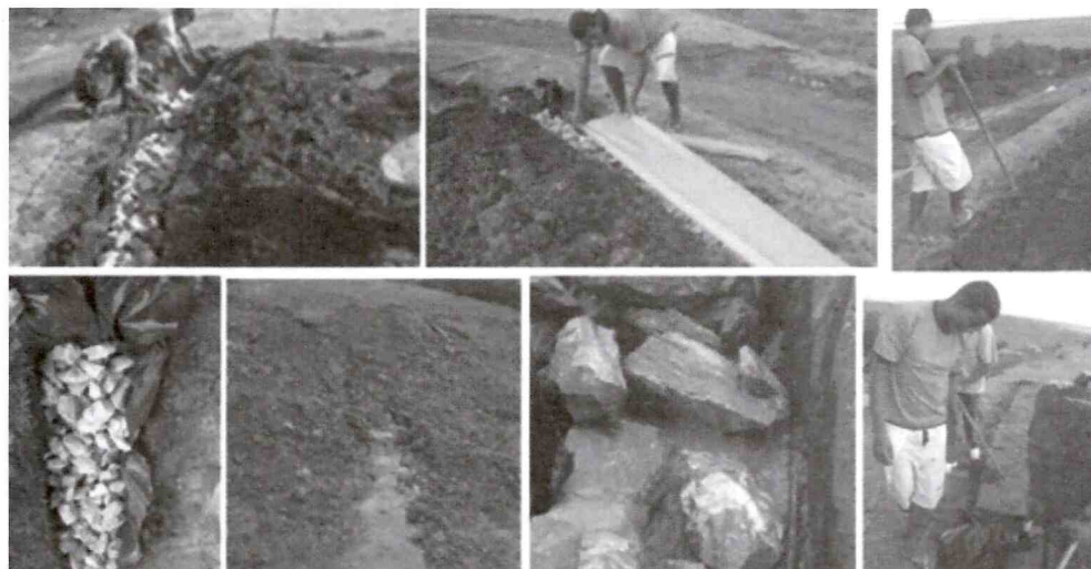
FIGURA 12 – Construção de drenos. Fotos: Mara Araujo/mar. 2006.
