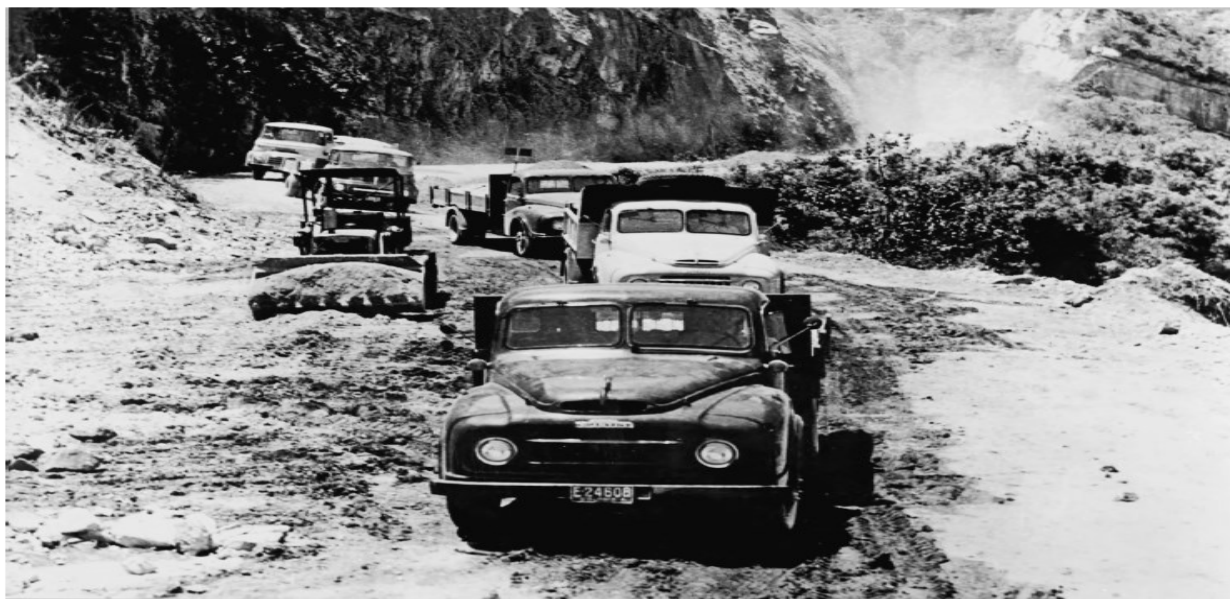
Figura 3 – Caminhões se movendo lentamente ao longo de uma estrada de montanha fora de Bogotá. Em 1961, o Banco Mundial e a Associação Internacional de Desenvolvimento forneceram 39 milhões de dólares para a Colômbia para um programa de melhoria de rodovias projetado para resolver a condição de suas estradas, conforme captado nesta fotografia.
