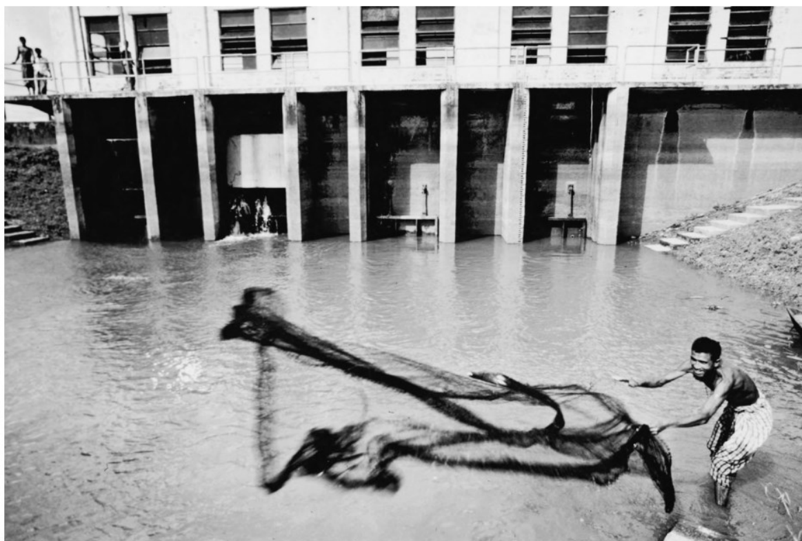
Figura 6 – Com crédito do governo sueco e da Associação Internacional de Desenvolvimento e subvenção canadense, este projeto, aprovado em 1972, visava a aumentar a produção e o emprego em Bangladesh, por meio da construção de sistemas de irrigação e do apoio à agricultura. Foto: Thomas Sennett, 1974. Pasta ID 1716085, Arquivos do Grupo Banco Mundial: CC BY NC SA 4.0.
